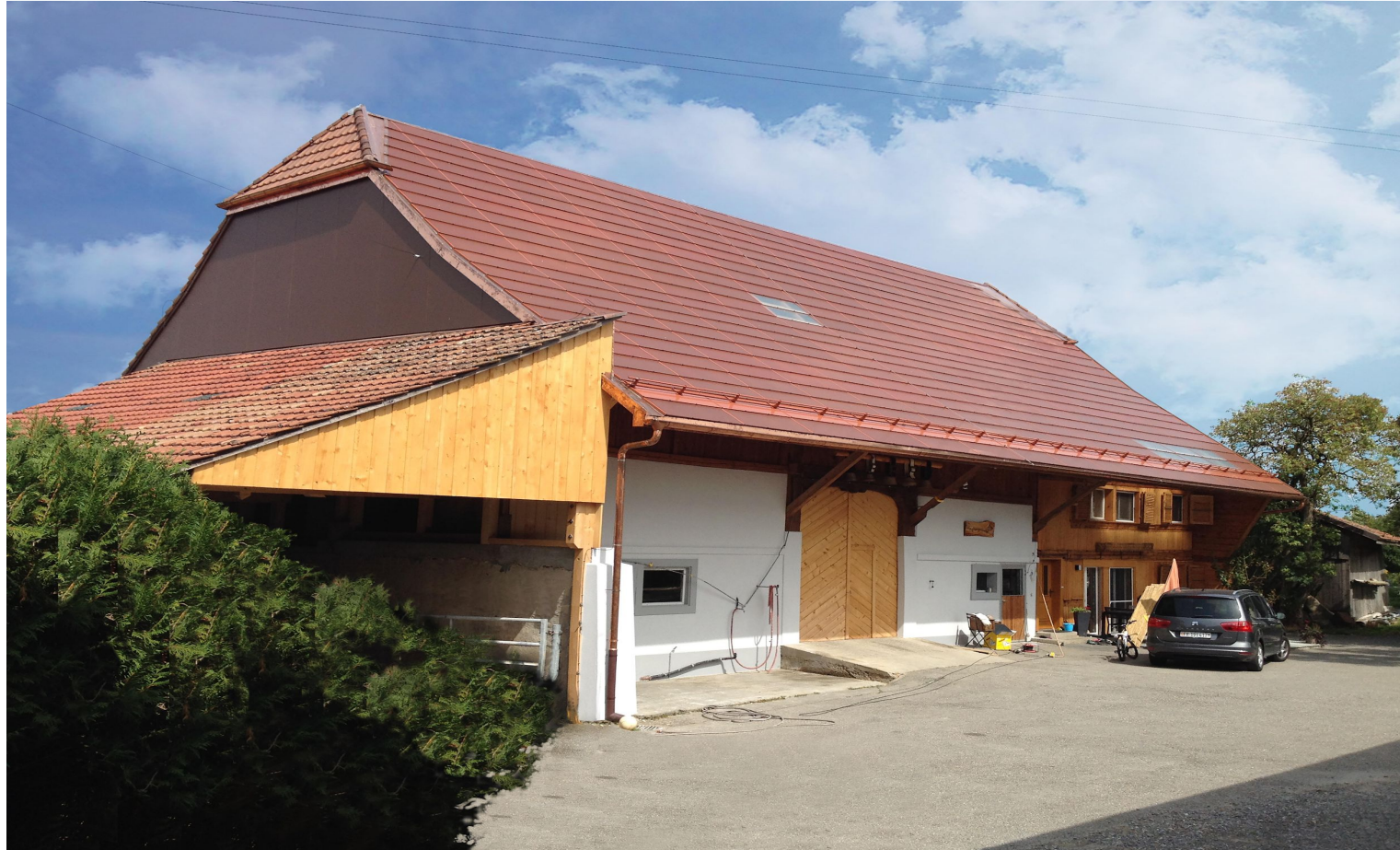
Renovierung eines Bauernhofes (Ecuwillens) Farbige Photovoltaische Solarpanele
