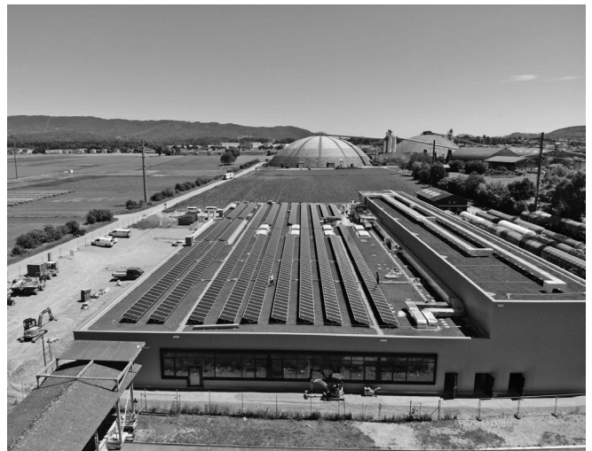
Gemeinschafts-Photovoltaikanlage mit einer Grösse von 267 kWp auf dem Swisslos-Logistikcenter-Neubau mit spezieller Modulaufständerung und gleichzeitiger Dachbegrünung
