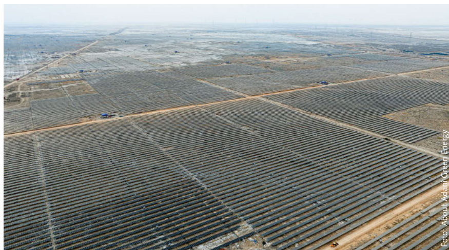
In Khavda wurden rund 2,4 Millionen bifaziale Solarmodule installiert.
