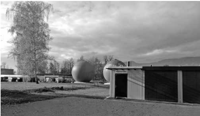
Gasspeicher beim Hybridwerk
